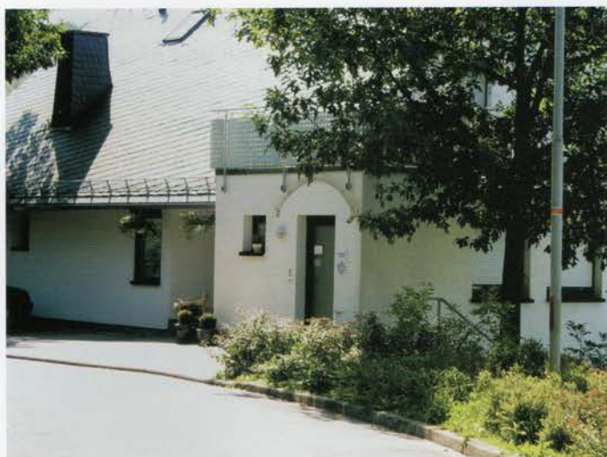
Die Aufstockung des Pfarrhaus der Evangelischen Kirche wurde auch von der Dorferneuerung bezuschusst.
