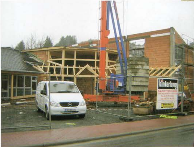
Der Bau wächst von Tag zu Tag
